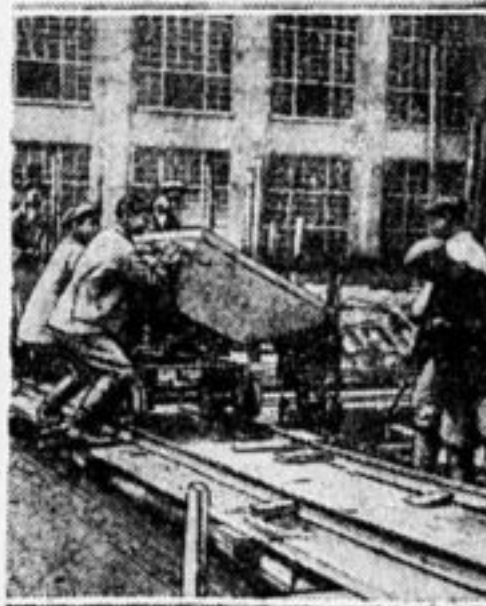
На постройке харьковской электрической станции ЭСХАР. Заливка бетоном строящейся плотины.
