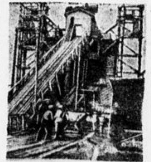
Цементно-бетонный завод на постройке «Сельмашстрой» в Ростове-на-Дону.
