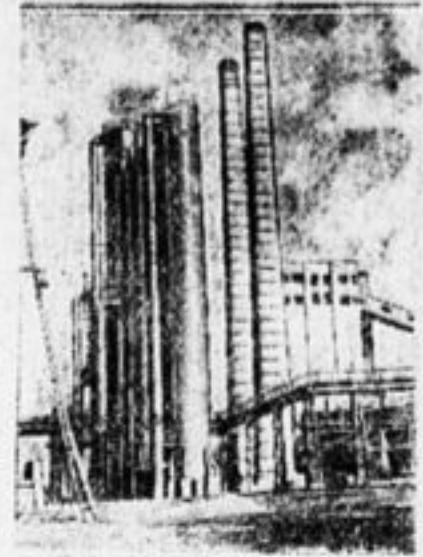
На снимке: Общий вид шахты № 8. Горловка.
